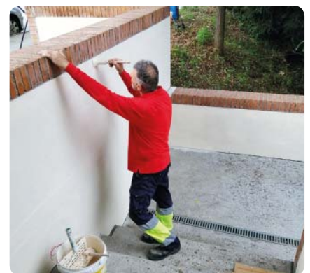
Tasques de conservació i manteniment de les escales que connecten l'avinguda Coronel Estrada amb el carrer Sieira Sanmartín.
